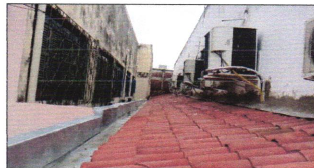
Instalação de calha, rufo e retelhamento
