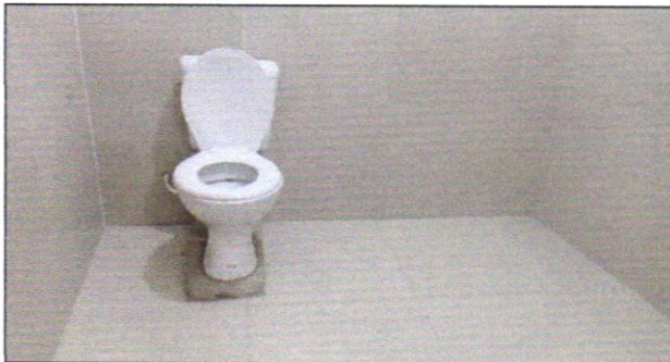
Assentamento do vaso sanitário do banheiro adaptado térreo
