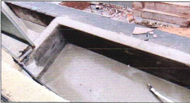
Impermeabilização da laje da ouvidoria e sala de som
