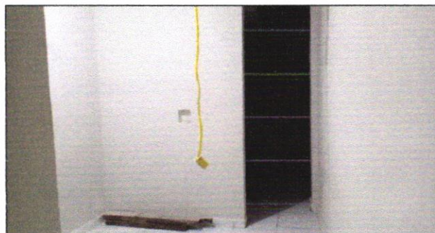
Pintura e piso cerâmico almoxarifado térreo
