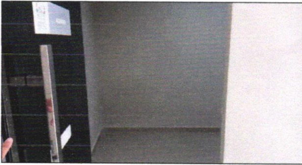
Pintura e impermeabilização da ouvidoria e sala de som
