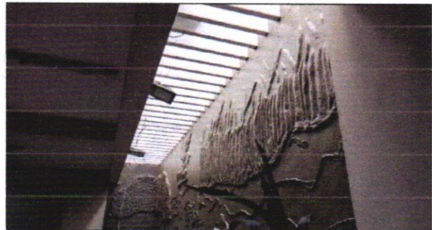
Substituição das pérgolas de concreto
